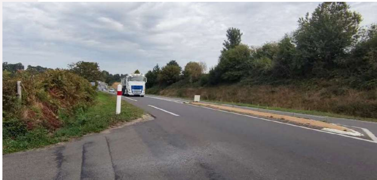
Une départementale concernée par le trafic poids lourds (SCE) Photographie prise sur le secteur sud au niveau de la route de l'Ansaudière
