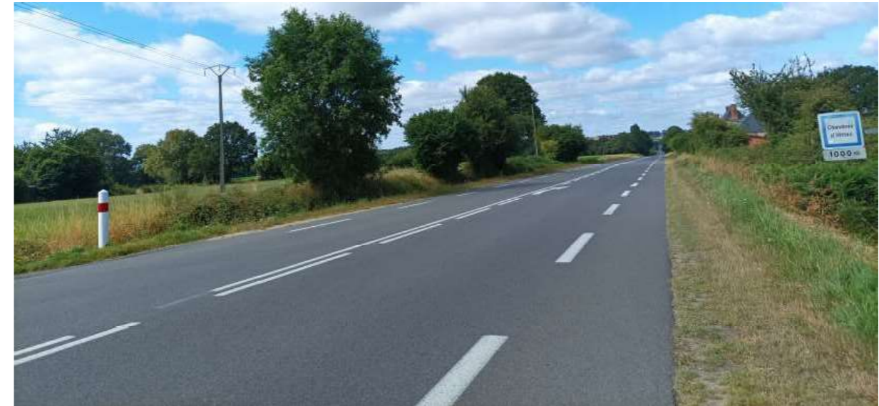
Absence de trottoirs et d'aménagements cyclables (SCE) Photographie prise sur le secteur sud au niveau du lieu-dit : « l'Hommeau »
